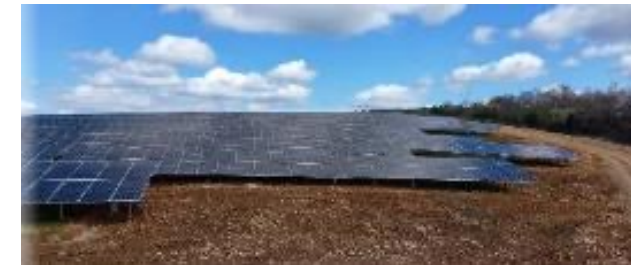
Centrale au sol, Les Mées (5,5 MW)
