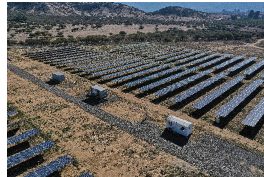
Centrale de Cancha, Chili (3 MW)
