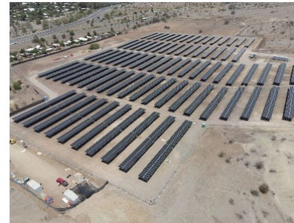
Centrale de Los Tauretes, Chili (3 MW)
