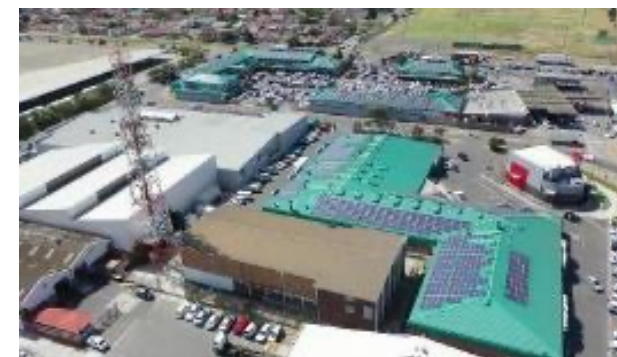
Centrale de Viking Park, Afrique (0,5 MW)
