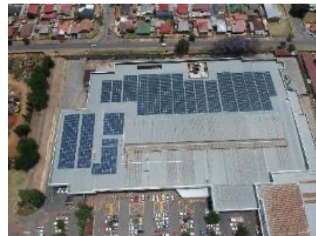
Centrale de Pick N Pay, Afrique (1 MW)
