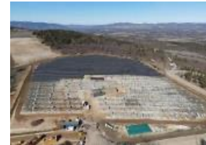
Chantier, centrale de Brouville (2,6 MW)
