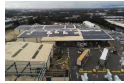
Centrale en toiture, VICAT (0,6 MW)
