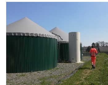
Centrale Nouzilly (1,4 GWh/an)
