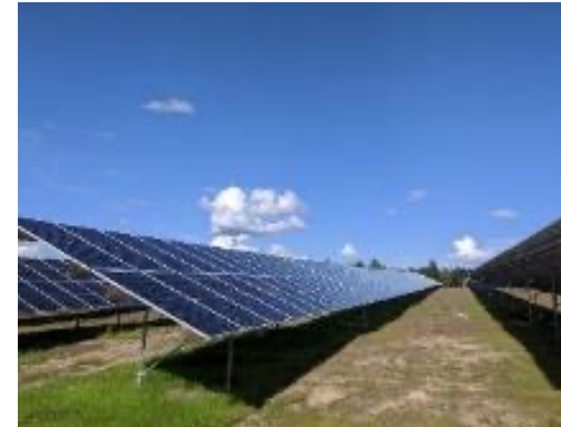
Centrale de Tolland, Amérique du Nord (6,7 MW)
