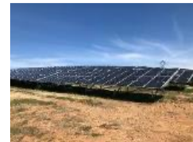
Centrale au sol, Bissey (5,6 MW)
