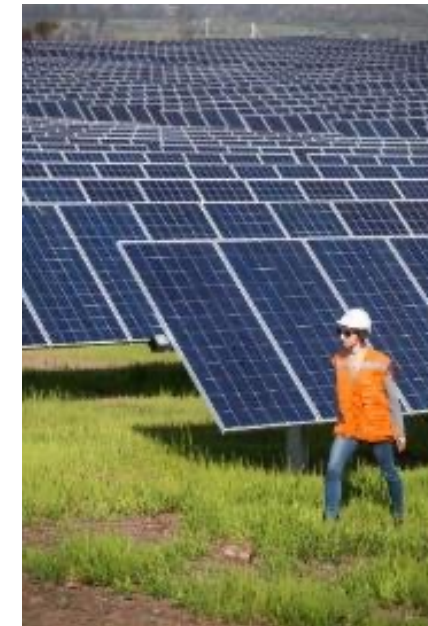
Centrale de San Francisco, Chili (3,6 MW)
