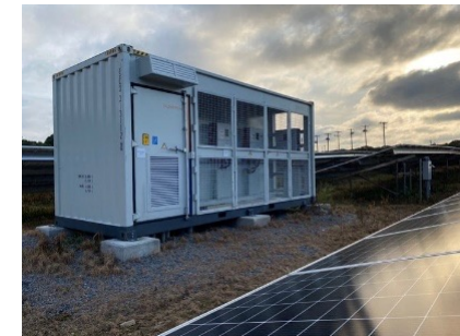
Centrale d'Apollo et batterie, Amérique du Nord (3,5 MW et 1,2 MW)
