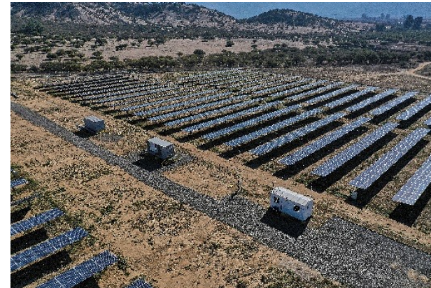
Centrale de Cancha, Chili (3 MW)
