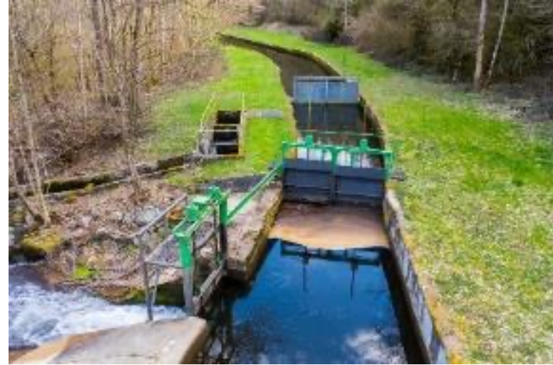
Centrale de Chizonnet (1,1 MW)
