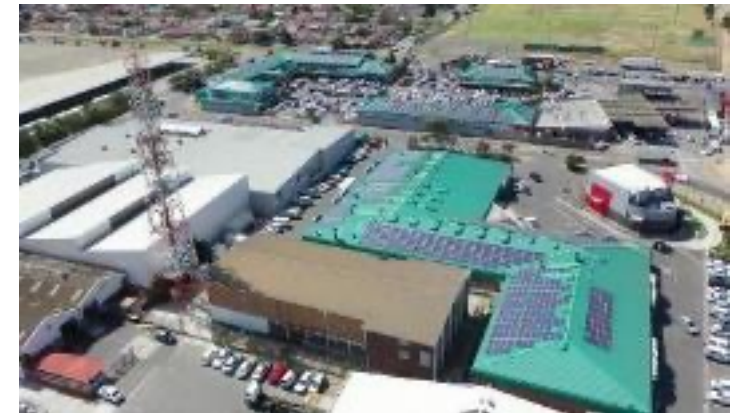
Centrale de Viking Park, Afrique (0,5 MW)
