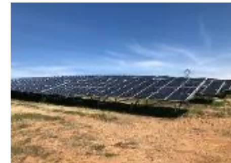
Centrale au sol, Bissey (5,6 MW)
