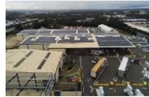
Centrale en toiture, VICAT (0,6 MW)
