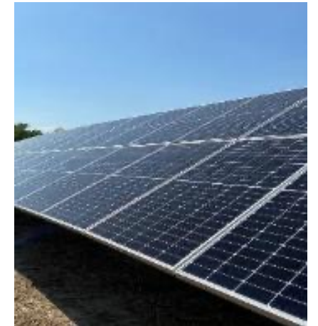
Centrale de Westport, Amérique du Nord (3,3 MW)
