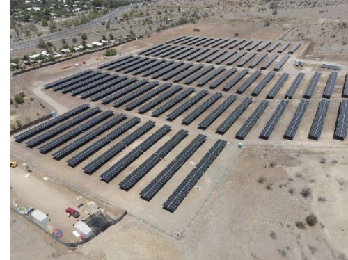
Centrale de Los Tauretes, Chili (3 MW)
