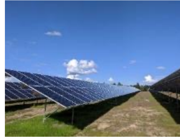
Centrale de Tolland, Amérique du Nord (6,7 MW)
