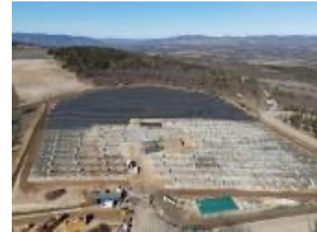
Chantier, centrale de Brouville (2,6 MW)
