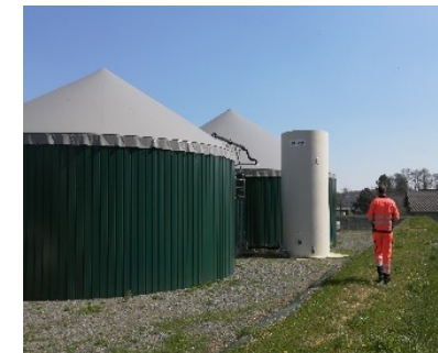
Centrale Nouzilly (1,4 GWh/an)
