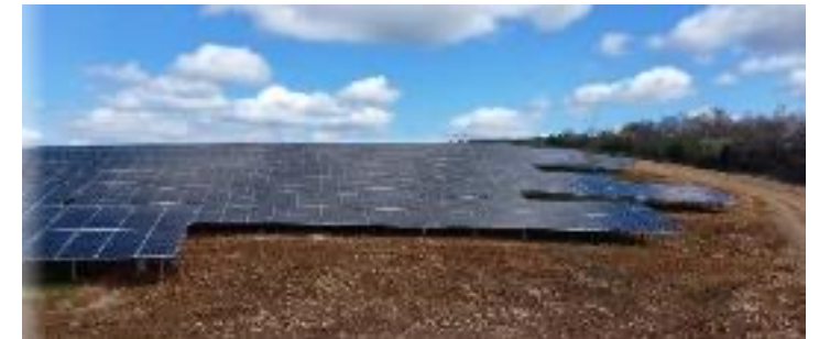
Centrale au sol, Les Mées (5,5 MW)
