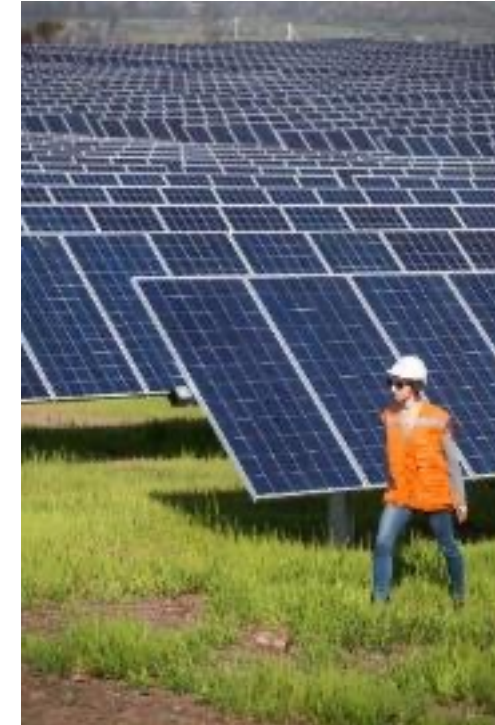
Centrale de San Francisco, Chili (3,6 MW)
